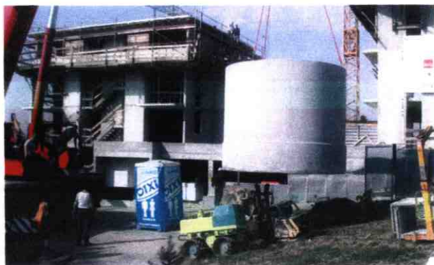
Einbau der Zisternen
