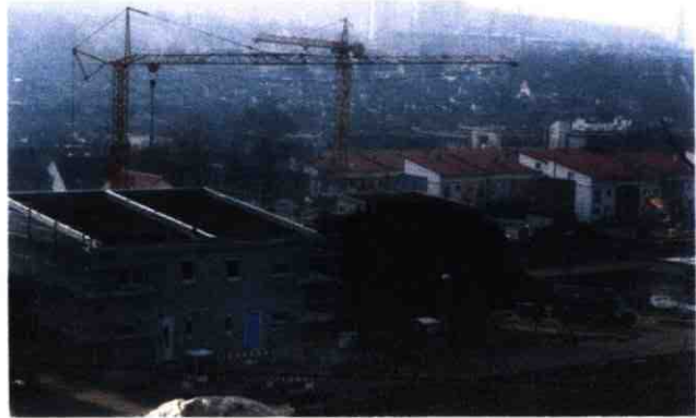
Pultdächer nach Aufbringung der Substratschicht
