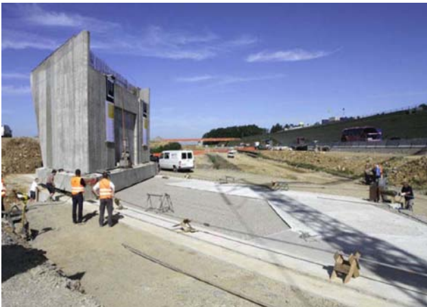
Bild 6: Verschieben Widerlager Süd
