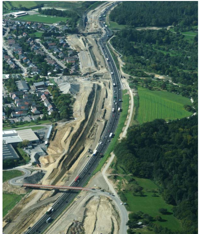
Bild 1: Bauabschnitt 3, Phase 4, Blick Richtung Westen, im Vordergrund die Behelfsbrücke
