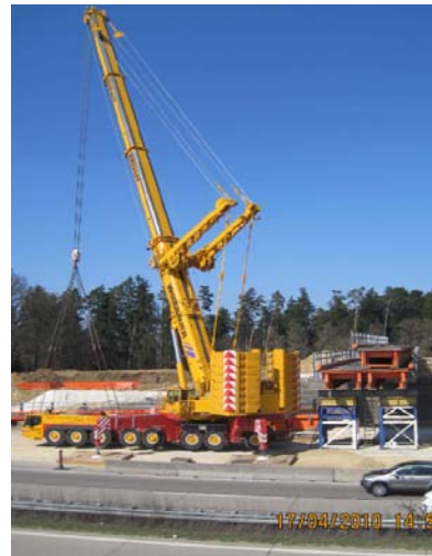
Bild 5: Blick auf nördliches Brückenfeld und 500t-Autokran
