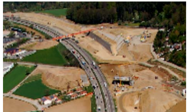
Bild 3: Blick Richtung Westen auf neue ÜBF L1180 im Bau (Vordergrund) und Behelfsbrücke (Hintergrund)
